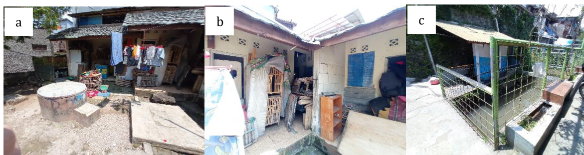
Gambar 2. Kondisi eksisting tangki septik; a) Tangki septik biodigester; b) MCK Plus (PDAM & ESP-USAID); c) MCK (SANIMAS).
